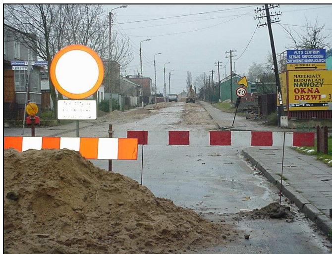
Prace przy budowie kanalizacji w ulicy Rawskiej
