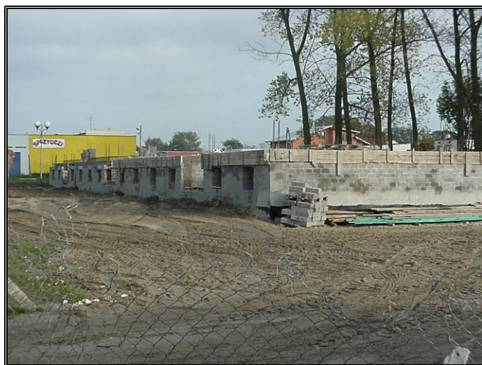
Plac budowy nowego bloku
