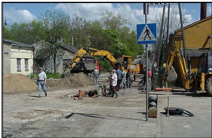
Budowa kolektora na skrzyżowaniu ulicy Zarzeczna i Rawskiej -zdjęcie z czerwca br.
