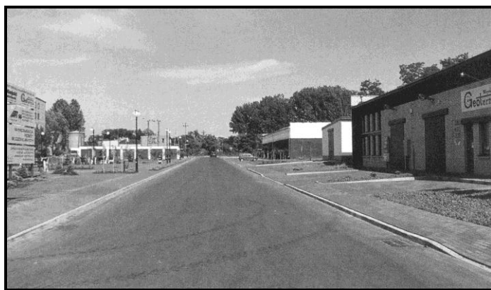
Nowo pobudowany odcinek ulicy Sienkiewicza - maj 2000 r
