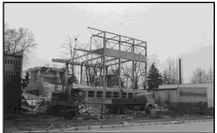
Wyburzanie starej kotłowni - luty 2000 r
