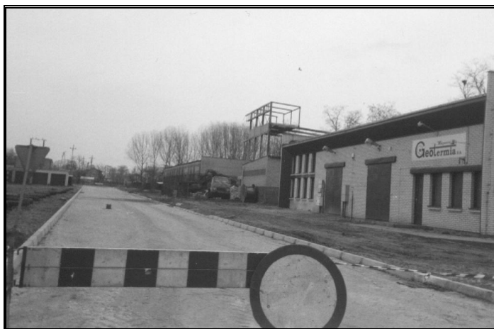
Budowa ulicy Sienkiewicza - marzec 2000 r.
