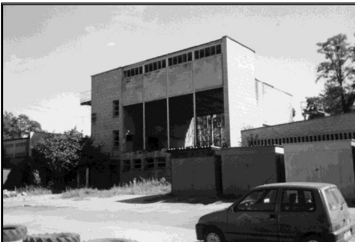
Stara kotłownia węglowa - sierpień 1998 r.
