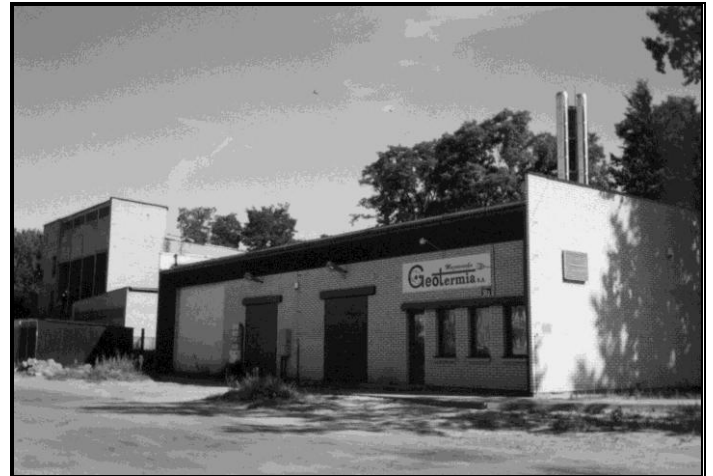
Ciepłownia geotermalna - sierpień 1998 r
