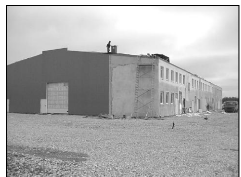
2001 Firma MOSTVA uruchomiła na swym terenie wartość 7 mln USD halę do technicznej obsługi samochodów.
