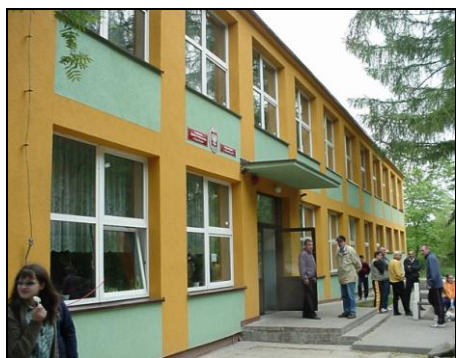
2001/02 W Szkole Podstawowej w Osuchowie przeprowadzono prace remontowe związane z wymianą okien i położeniem zewnętrznej termoizolacji.
