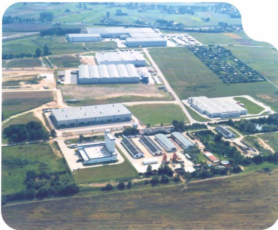
Widok dzielnicy przemysłowej
