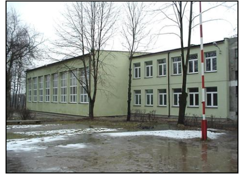
2001 W Osuchowie dokonano oficjalnego otwarcia sali gimnastycznej, jaka pobudowana została przy miejscowej szkole podstawowej. Jednocześnie oddane zostało do użytku nowe skrzydło szkolnego budynku w którym mieści się gimnazjum.
