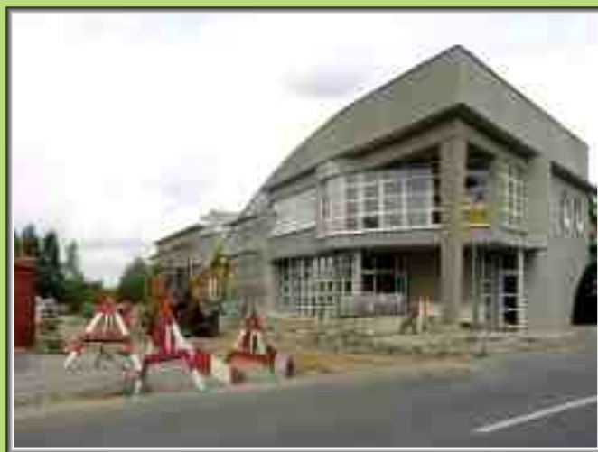
Modernizacja Mszczonowskiego Osrodka Kultury
