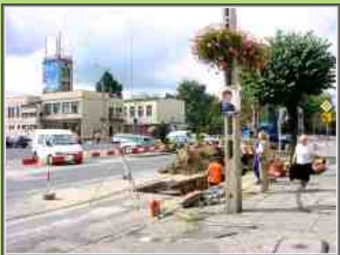
Budowa kanalizacj w ulicy Warszawskiej i Nowym Rynku
