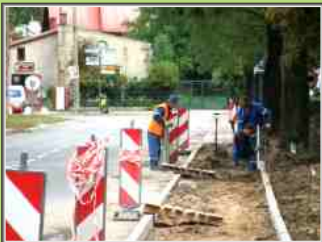
Budowa chodnika przy ulicy Dworcowej
