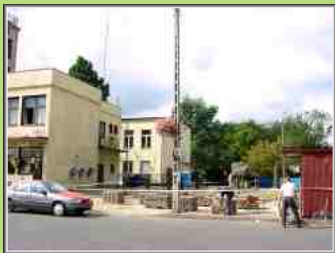
Przygotowanie terenu pod odbudowę ratusza
