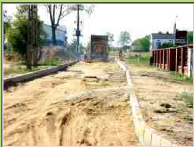
Budowa ulicy na osiedlu Józefowska
