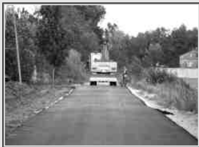
Budowa drogi we wsi Olszówka (okolice Wręczy): długość 500m, inwestycja współfinansowana z Funduszu Ochrony Gruntów Rolnych
