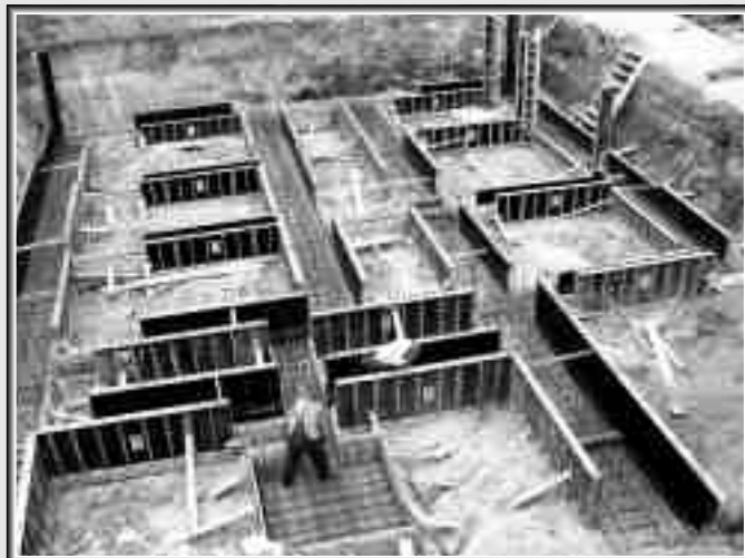
Budowa ratusza - przygotowanie fundamentów
