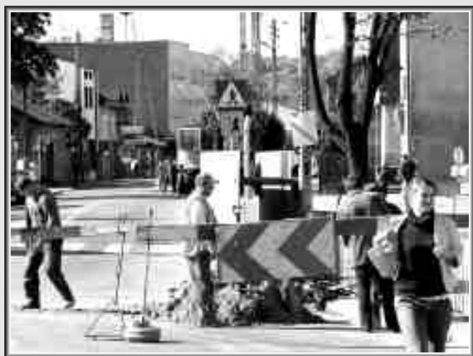
Budowa kanalizacji i wodociągu w ulicach Warszawskiej oraz Tarczyńskiej
