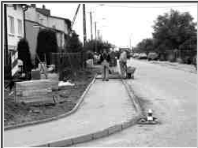
Budowa chodników na osiedlu Kwiatowa
