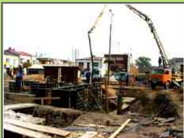
Budowa fundamentów ratusza
