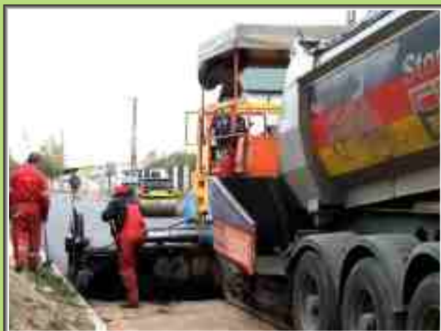
Budowa ulic na osiedlu Józefowska
