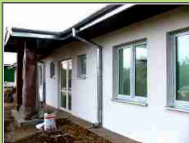
Budowa budynku komunalnego w Gąbie
