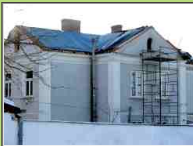
Początek prac remontowych plebanii (inwestycja realizowana przez Parafię p.w. Świętego Jana Chrzciciela w Mszczonowie)
