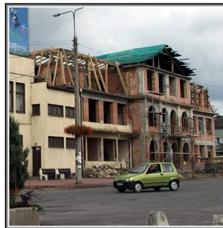
Ratusz już niebawem pod dachem.
