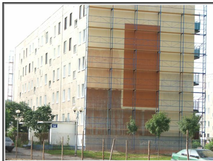
Termomodernizacja bloków na osiedlu Dworcowa III
