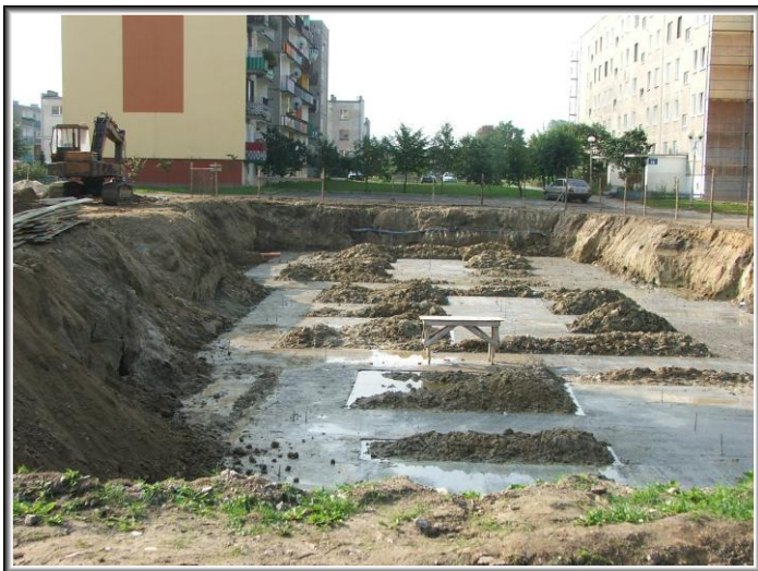
Fundamenty kolejnego bloku na osiedlu Dworcowa III
