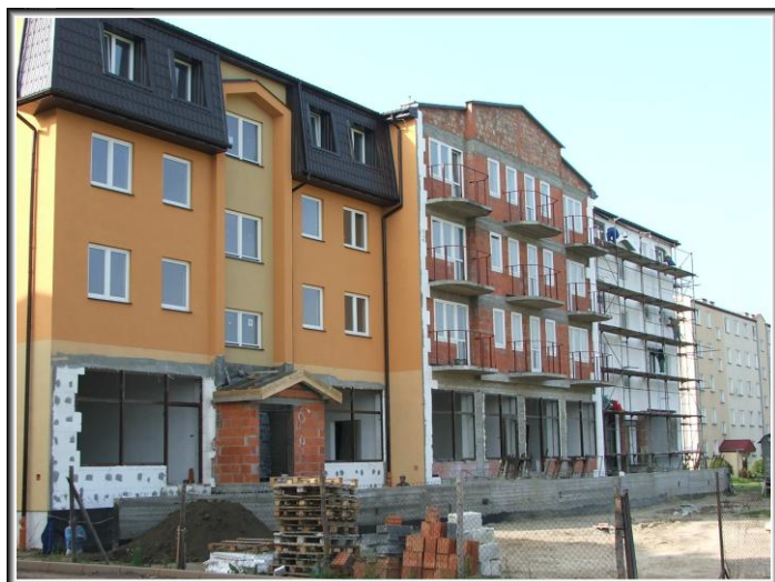
Prace wykończeniowe nowego bloku przy ulicy Północnej
