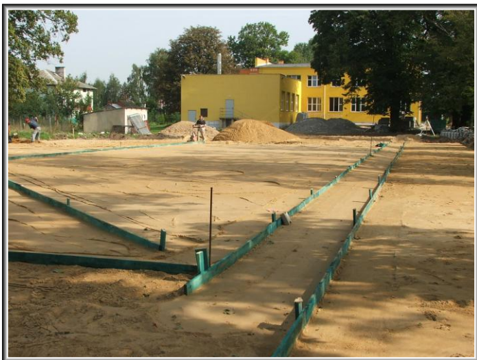
We Wręczy trwa budowa terenu sportowego za szkołą (patrz: zdjęcie), a także budowa wiejskiego wodociągu.
