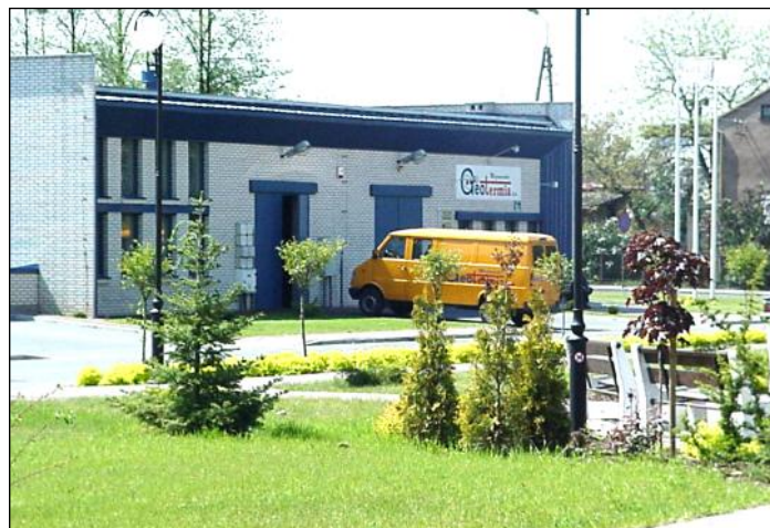
Ciepłownia geotermalna przy ulicy Sienkiewicza
