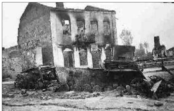
Zniszczony niemiecki czołg PzKpfw IV na ulicy Rawskiej
