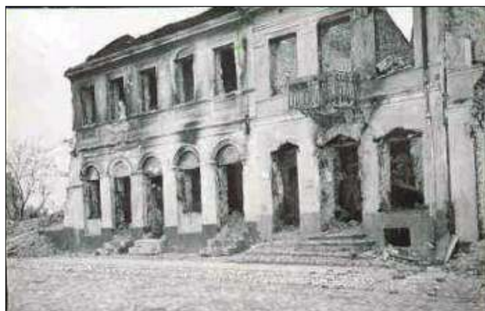
Zniszczone kamienice na Placu Piłsudskiego (ściana zachodnia)
