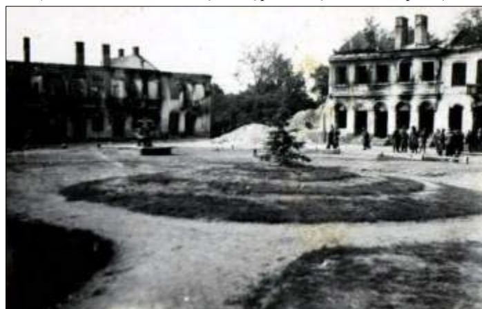
Zniszczone kamienice na Placu Piłsudskiego (ściana południowa i zachodnia)
