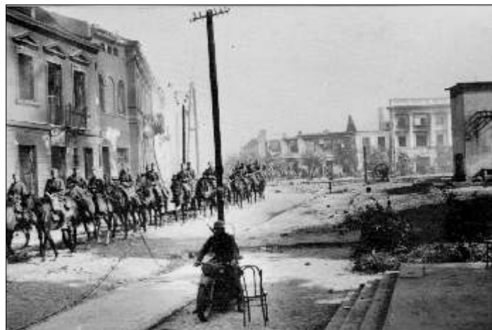
Ulica Żyrardowska - widok na zniszczony ratusz
