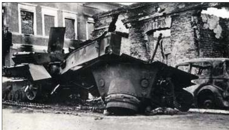
Zniszczony niemiecki czołg na ulicy Rawskiej
