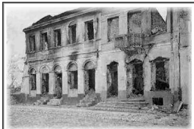
1939 Zniszczone kamienice na Placu Piłsudskiego (ściana zachodnia)
