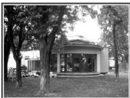
Przedszkole w Mszczonowie po przebudowie
