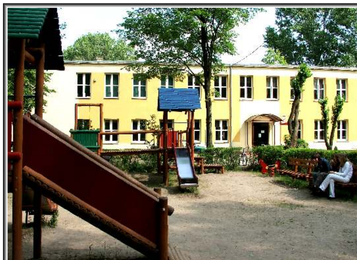
Szkoła Podstawowa w Lutkowie z przestronną salą gimnastyczną
