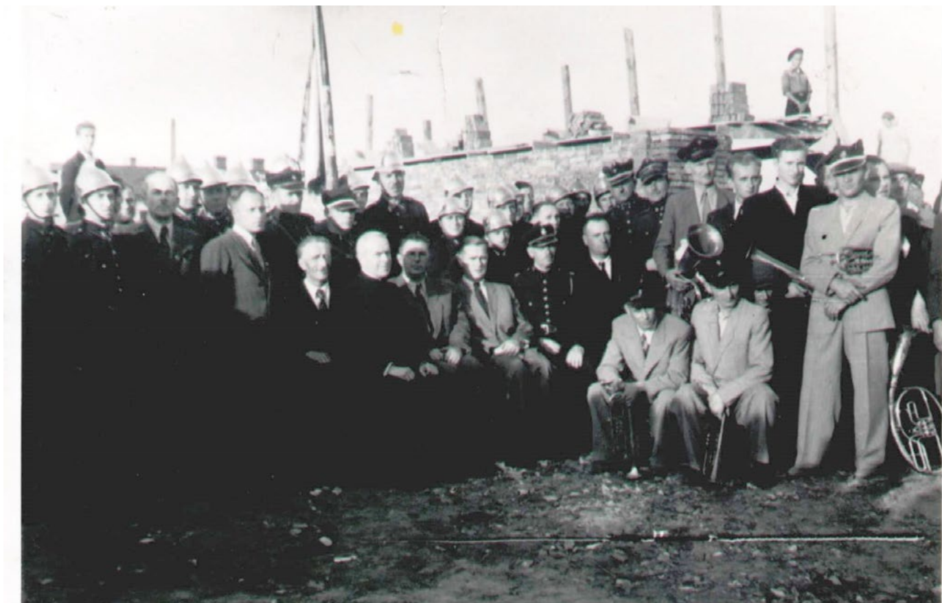
Budowa remizy OSP Mszczonów
