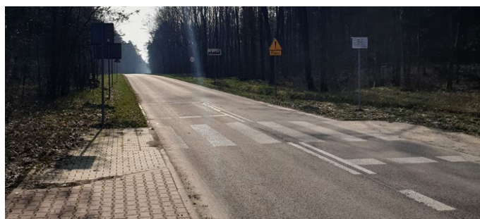
Przebudowa ulicy Białogórskiej w Osuchowie
