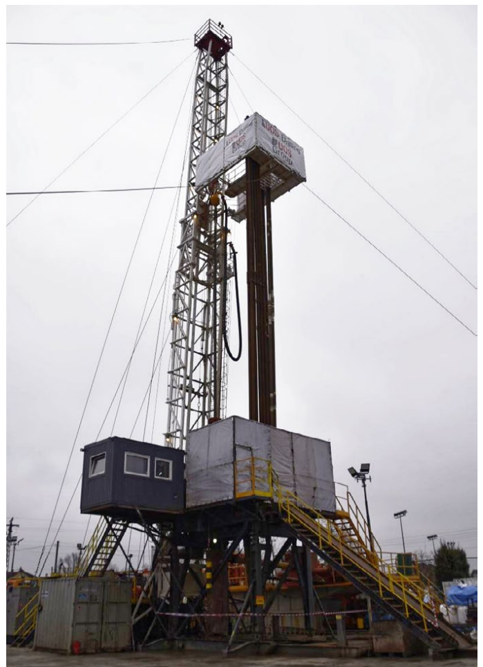
Nowy odwiert - Geotermia Mazowiecka
